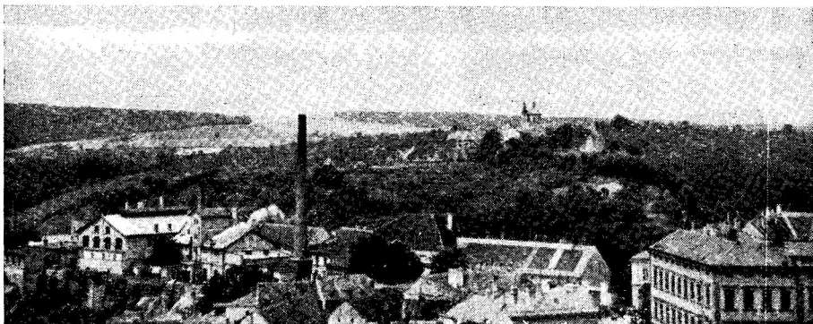
Obr. 6. Celkový pohled na Znojmo-Hradiště. — Foto: Dostál—Ševčík.
