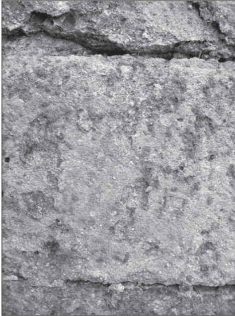
Obr. 6. Hrad Lukov, detail líčové partie kvádrů v jižní fasádě jižního pylonu, s plochami líček. Foto R. Vrla, 2004.
