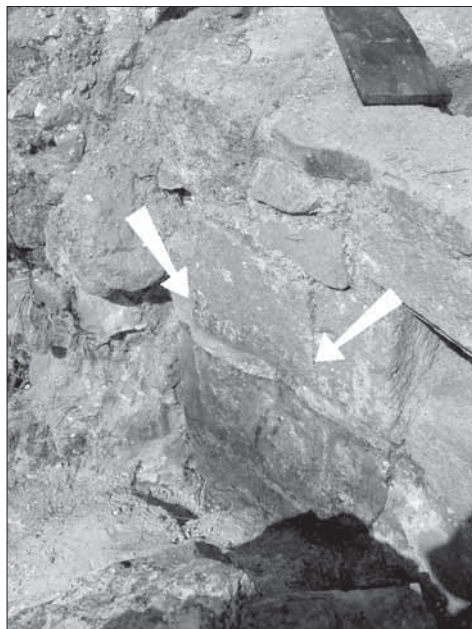
Obr. 9. Hrad Lukov, kruhová věžice, detail koruny torza, pohled od jihovýchodu na čelo „břítu“ vystupujícího z těla věže. Foto R. Vrla, 2004.
