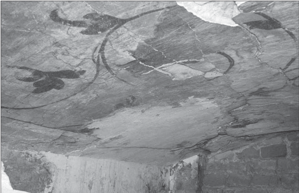
Obr. 12. Uherský Ostroh. Pohled na záklenek velké niky v severozápadní zdi věže. Na povrchu patrný fragmenty malby s vegetabilním motivem. Pohled z interiéru místnosti.
