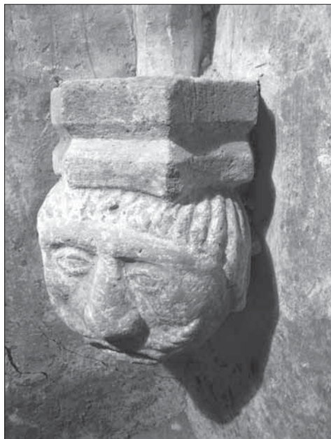
Obr. 5. Uherský Ostroh. Klenební konzola v severním koutě místnosti.
