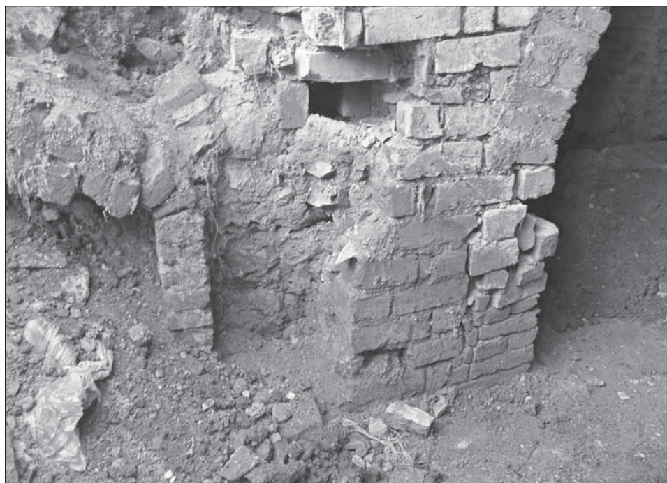
Obr. 7. Detail jižního ostění vstupu do sklepa objektu CO16 s patrným vytrhnutým kamenným ostěním a otvorem pro závoru. Foto archiv Archaia Brno, o. p. s. (inv. č. 08677-2008).
