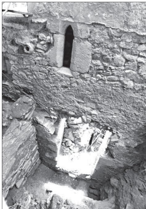
Obr. 4. Výsek zdiva s románským portálem (fáze A) a gotickým oknem (fáze B). V popředí je zachycen relikt přizděné předsíně (fáze C). Pohled od jihu. Archaia Brno, o. p. s.
