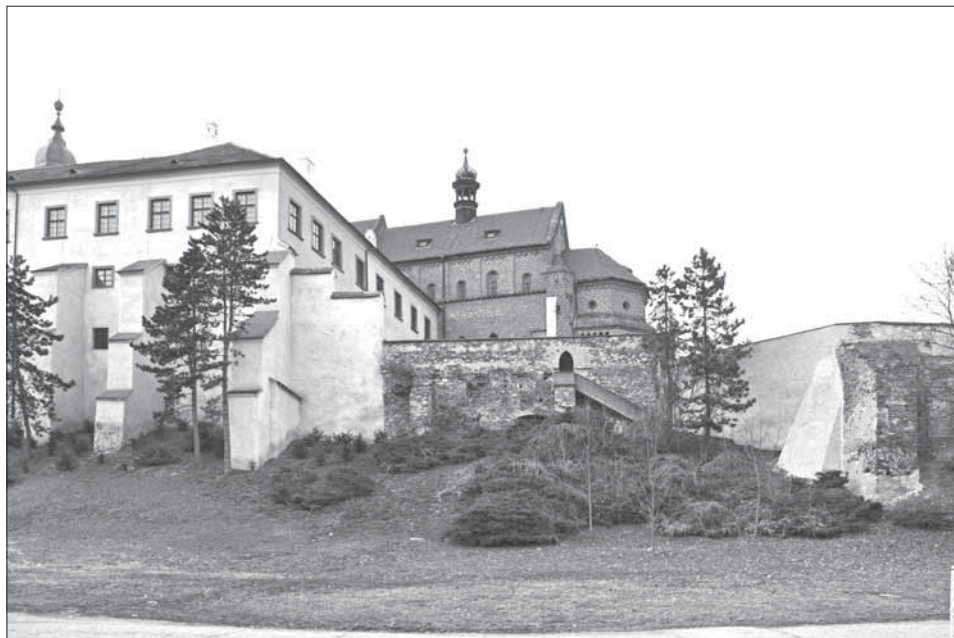
Obr. 1. Celkový pohled na areál benediktinského opatství od jihu. Uprostřed snímku dokumentovaný úsek ohradní zdi. Foto archiv Archaia Brno, o. p. s.
