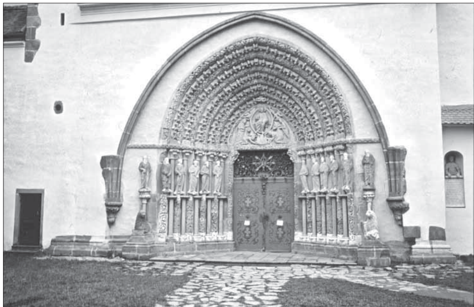
Obr. 9. Tišov, západný portál. Foto autor.
