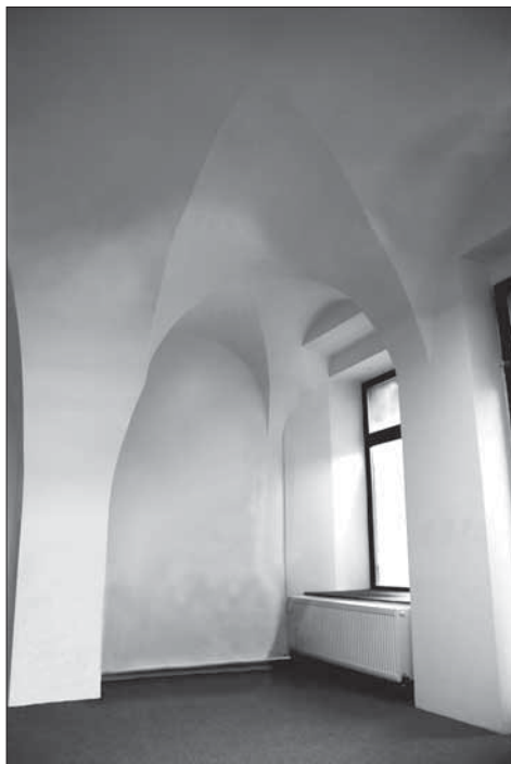
Obr. 7. Dům č. p. 199. Koutová klenba v neckovém sklenutí. Foto L. Kursová.
