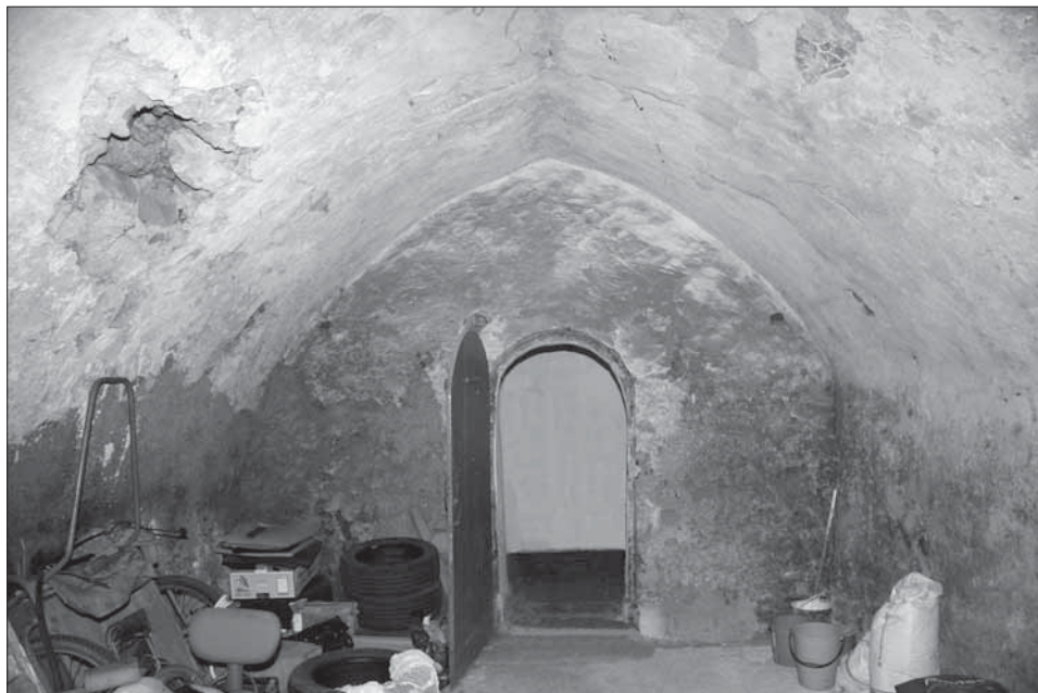
Obr. 3. Dům č. p. 10. Komora s valenou lomenou klenbou hloubkové orientace. Foto L. Kursová.
