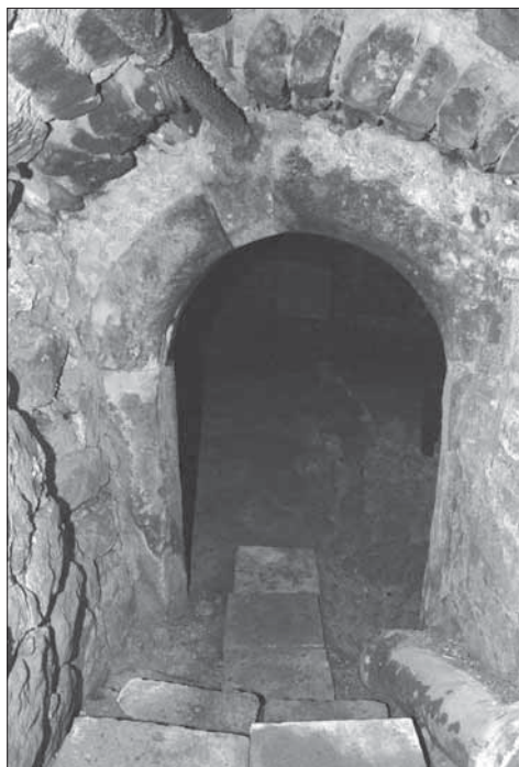
Obr. 4. Dům č. p. 10. Portál vstupu do sklepa s prostým okosením. Foto L. Kursová.
