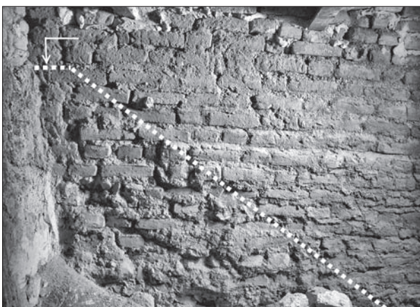
Obr. 10. Na exteriérovom líci východnej steny naznačená línia rozhrania medzi upravenou a neupravenou plochou muriva. Šípka označuje predpokladanú polohu pôvodného vonkajšieho terénu na kóte -85 cm voči terénu dnešnému dvora. Foto P. Grznár, M. Zelina.
