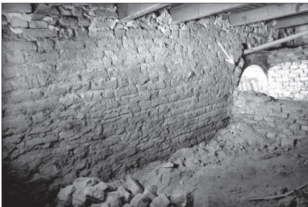
Obr. 9. Exteriérové líce východnej steny pivnice odkryté utilitárnym výkopom s fragmentom muriva staršej šije. Foto P. Grznár, M. Zelina.
