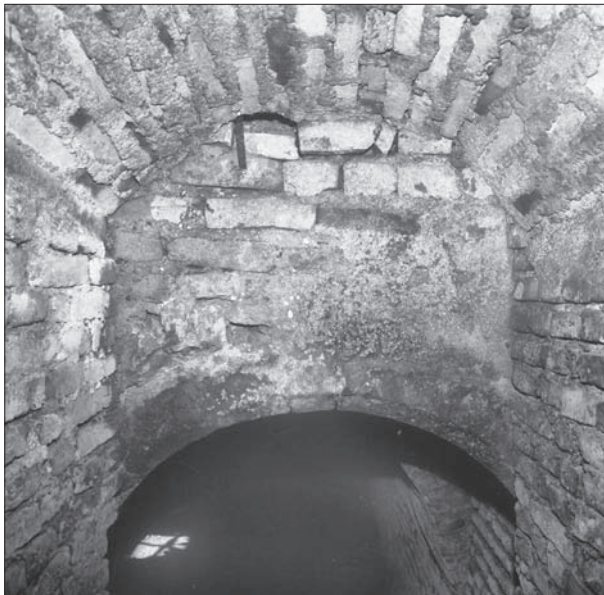
Obr. 8. Čelo klenby najmladšej šije v nadpraží nad portálom. Foto archív Krajského pamiatkového úradu Trnava.
