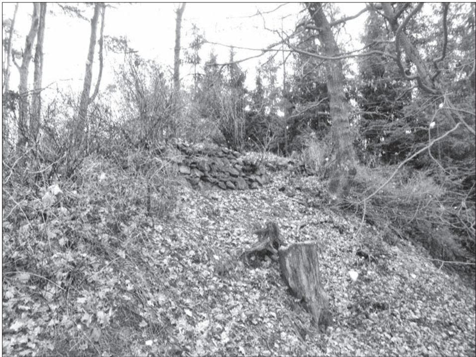
Obr. 9. Snímek stavební úpravy vrcholku valu v severozápadní části. Foto autoři.
