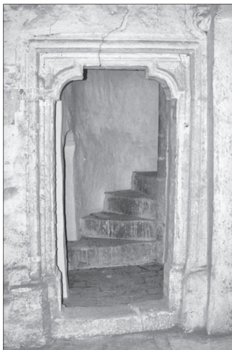
Obr. 9. Znojmo-Louka, kaple sv. Šebestiána. Portál severního úseku západní stěny vedoucí na točité schodiště v době započetí sondáže.
