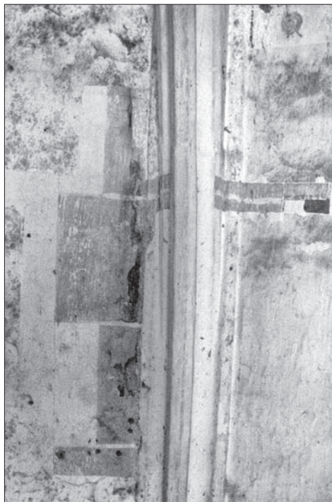
Obr. 13. Znojmo-Louka, kaple sv. Šebestiána. Sondáží odhalená dekorace žeber s iluzivním kvádrováním z roku 1487.
