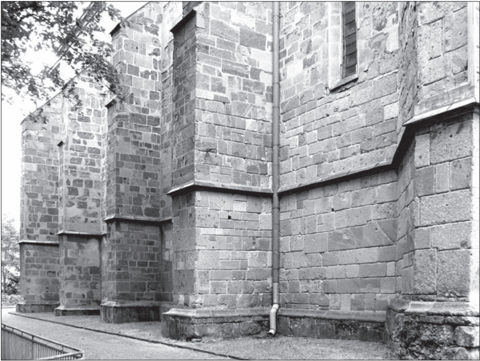
Obr. 6. Loď kláštorného kostola v Hronskom Beňadiku zo 14. storočia je obložená tufovými kvádrmi z miestneho kameňolomu. Foto D. Pivko.
