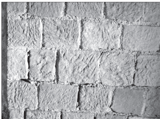
Obr. 10. Múr vo veži hradu Šomoška z 13. až 14. storočia má pieskovcové kvádre, nepravidelne upravené dvojšpicom (Zweispitz). Foto D. Pivko.
