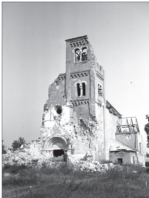
Obr. 11. Biňa (okr. Štúrovo). Bývalý premonštrátsky kostol po poškodení počas 2. svetovej vojny. Foto archív Pamiatkového úradu SR, sign. 345/37.
