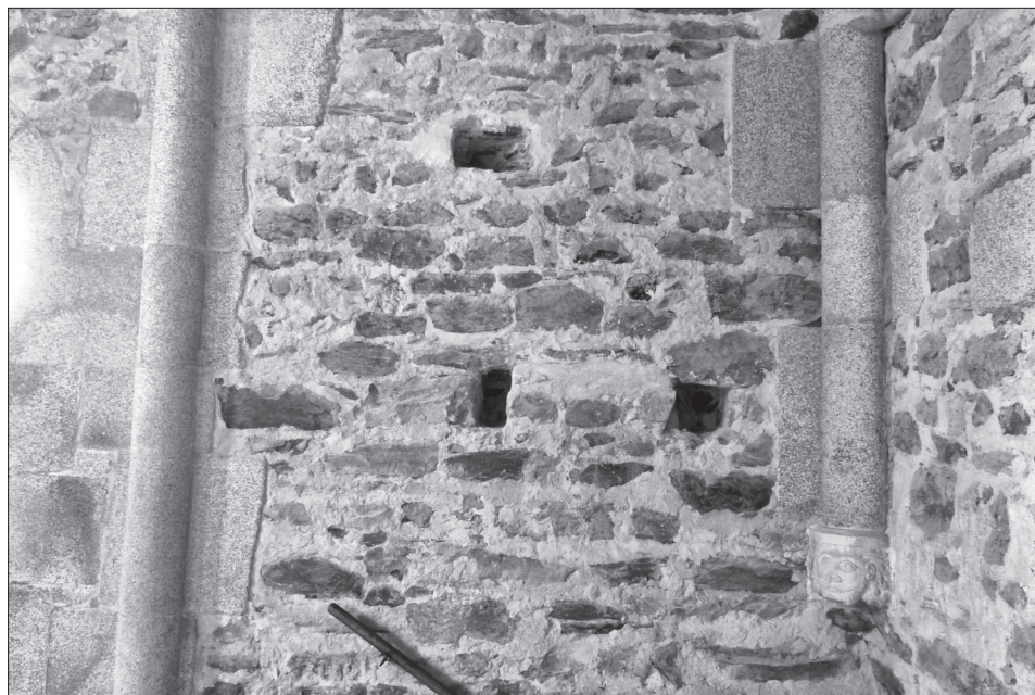
Obr. 9. Cheb, hrad. Kapsy po usazení kruchty pro hudebníky nad schody. Foto P. Šebesta, 2002.
