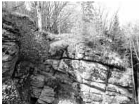
Obr. 19. Prostor nad budovou č. 2 s vyzdáním mezery mezi skalami a věží (věžičí) na skále.
