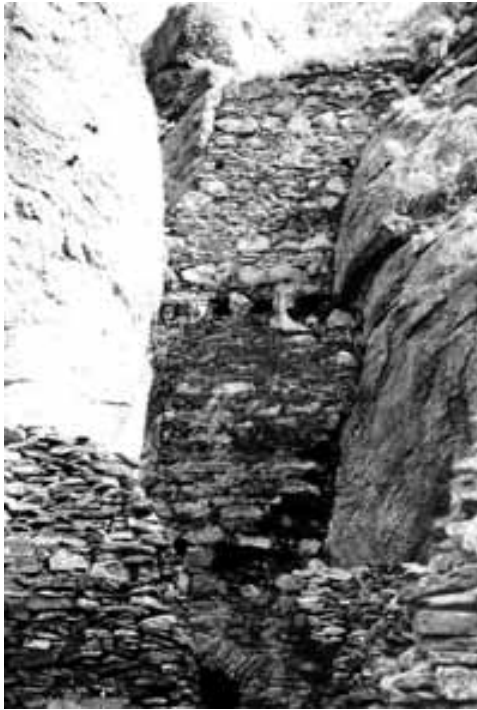
Obr. 5a, 5b. Vyzdívka severní strany východní stěny budovy č. 1 s brankou a s trámovými lůžky. 5a: pohled od západu. 5b: 1 – skalní masiv; 2 – kapsy pro uložení stropních a střešních trámů; 3 – body pětimetrové a metrové čtvercové sítě. Abb. 5a, 5b. Ausmauerung der Nordseite der Ostwand von Gebäude Nr. 1 mit Tor und Balkenlager. 5a: Blick von Westen. 5b: 1 – Felsenmassiv; 2 – Taschen zur Lagerung der Decken- und Dachbalken; 3 – Punkte des Fünf-Meter- und Meterrasters.
