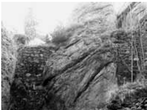
Obr. 3. Východní stěna budovy č. 1 se dvěma vyzdvíčkami. Pohled od západu.
