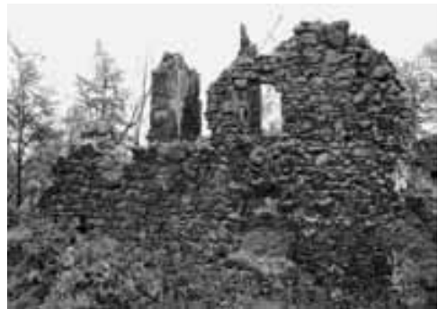
Obr. 7. Šumburk (okr. Chomutov). Nádvoří zeď levého traktu stavby tzv. paláce ve východním koutě nádvoří, pruty naznačují šikmé pásy hrázdné konstrukce. Foto I. Peřina, 2007.
