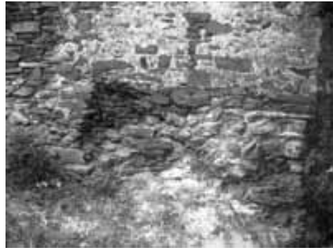
Obr. 12. Cimburk u Městečka Trnávky. Severovýchodní nároží jádra se začleněným starším zdívem, převrstveným pozdně gotickými, v nároží provázanými zdívy severního a východního křídla. Foto J. Štětina, 2007.
