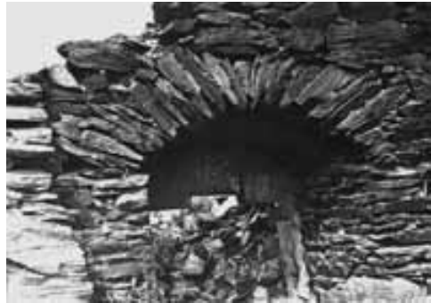
Obr. 18. Cimburk u Městečka Trnávky. Pozdně gotický portál zřejmě v jižní části západního křídla, stav v první třetině 20. století. Foto archiv NPÚ, ú. o. p. v Brně Abb. 18. Cimburk bei Městečko Trnávka. Spätgotisches Portal offenbar im Südteil des Westflügels, Zustand im ersten Drittel des 20. Jhdts. Foto Archiv des Nationalen Denkmalamts, Bezirksstelle Brno.
