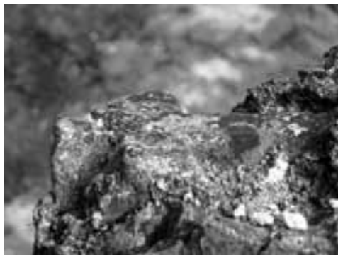
Obr. 4. Cimburk u Městečka Trnávky. Druhotně použitá část dělicího okenního kříže v pozdně gotické nadezdívce západní zdi předhradí. Foto J. Štětina, 2007.
