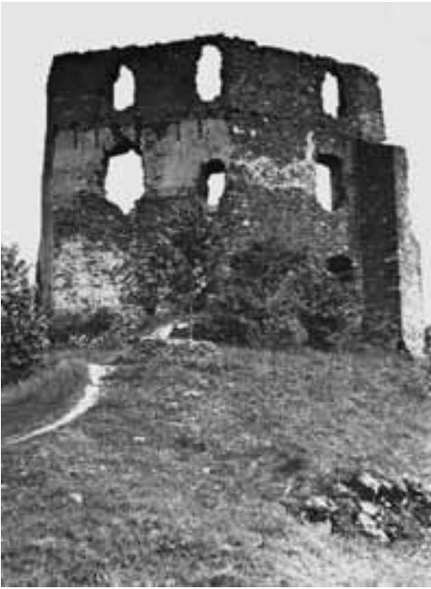
Obr. 11. Cimburk u Městečka Trnávky. Vnější průčelí severního obvodu jádra s patrnými stopami dřevěného ochozu počátkem 20. století. Foto archiv NPÚ, ú. o. p. v Brně.
