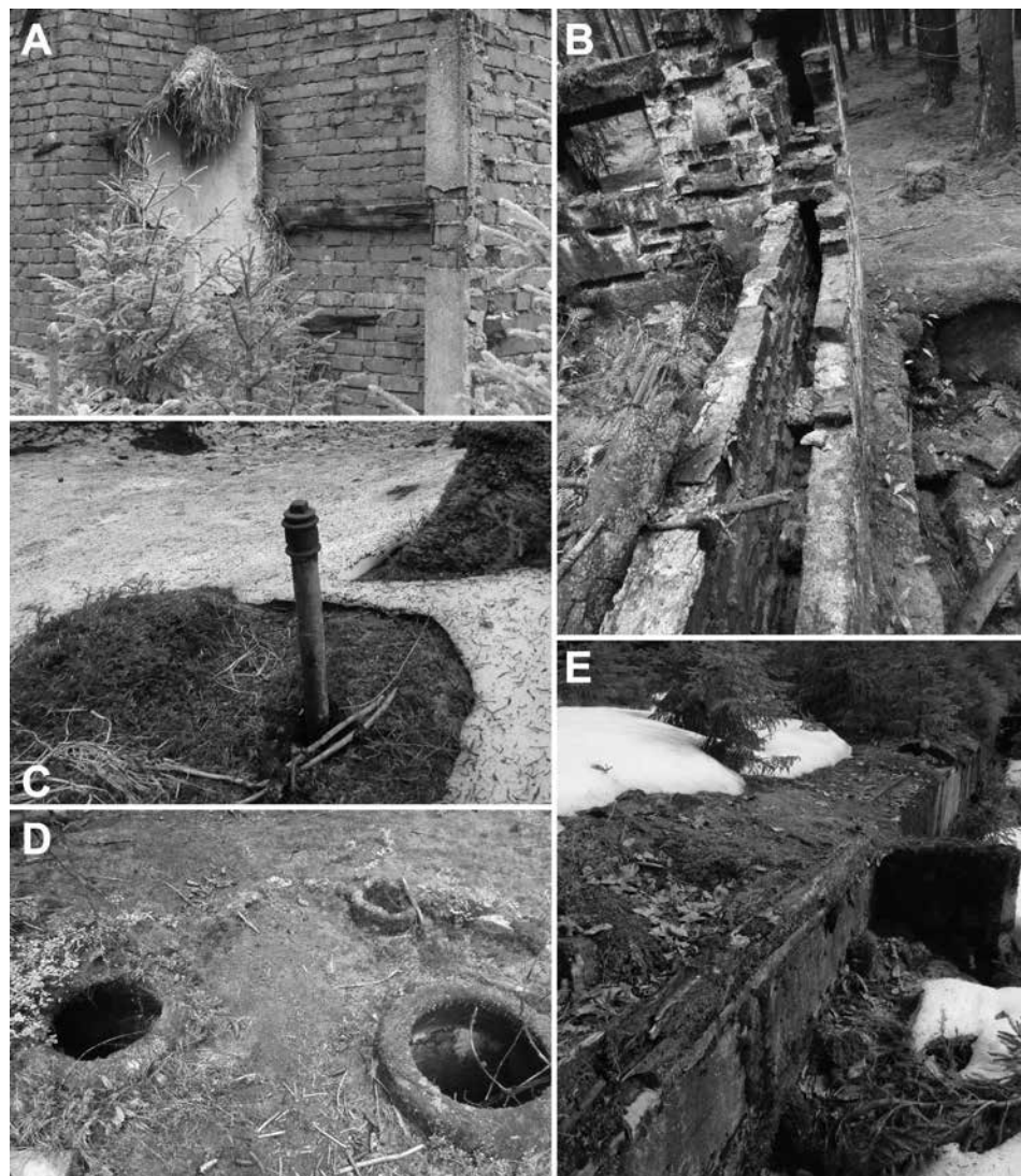
Obr. 6. Zachovalé technické detaily. A – zateplení stěn staveb (obj. 36); B – zdvojená zeď sprch (obj. 19); C – přípojka vodovodního potrubí (obj. 9); D – kanalizační šachty v nároží pochozí plochy (obj. 109; 110); E – zbytky dřevěné konstrukce stěny (obj. 50). Foto J. Hasil, 2013–2014.
