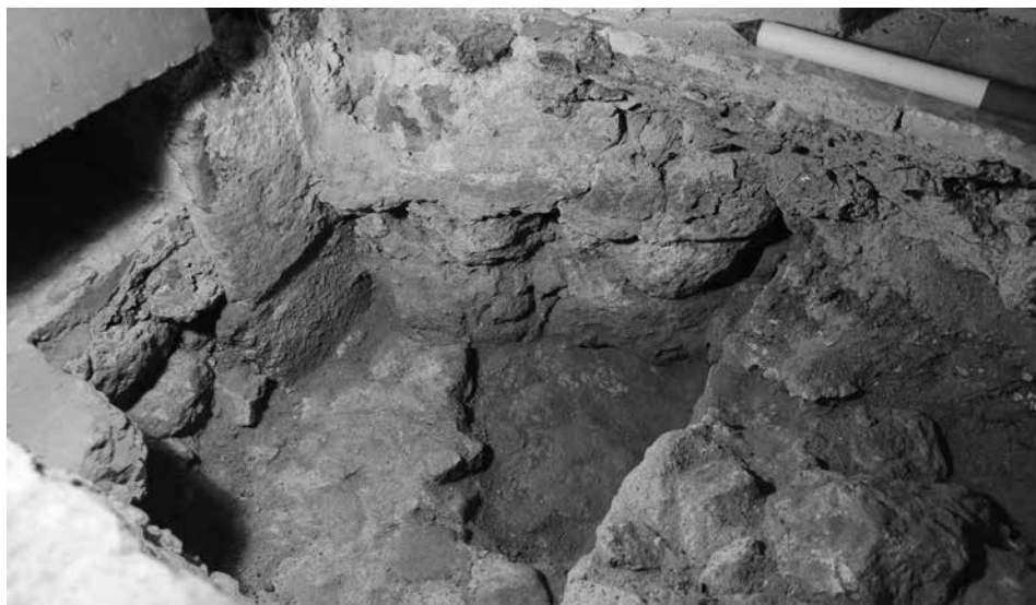
Obr. 6. Hronský Beňadik, Kostol sv. Egídia. Sonda VIII – ostenie západného portálu so zachovanou pôvodnou omietkou, v popredí klenba mladšej barokovej krypty a torzo tehlovej dlažby. Foto M. Hanuš.
