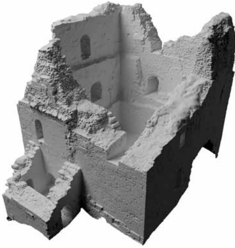
Obr. 8. Přimda, okr. Tachov. Současný vzhled donjonu na 3D modelu vytvořeném na základě laserového skenování. Zpracoval M. Kudrnovský, 2014. Abb. 8. Přimda, Bezirk Tachov. Derzeitiges Aussehen des Donjons als anhand von Laserscanning erstelltes 3D-Modell. Erstellt von M. Kudrnovský, 2014.
