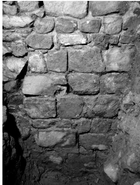
Obr. 6. Dolní Kounice, okr. Brno-venkov. Sonda 1 – severní stěna suterénu s kvádřikovým zdivem a gotickou „plombou“. Archiv Archaia Brno, o.p.s. Abb. 6. Dolní Kounice, Bez. Brno-Land. Sondierschnitt 1, Nordwand des Souterrains mit Quadersteinmauerwerk und gotischer „Plombe“. Archiv Archaia Brno, o.p.s.
