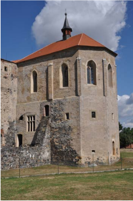
Obr. 2. Hrad Švihov, okr. Klatovy. Pohled na křídlo s kaplí. Foto J. Varhaník, 2015.
