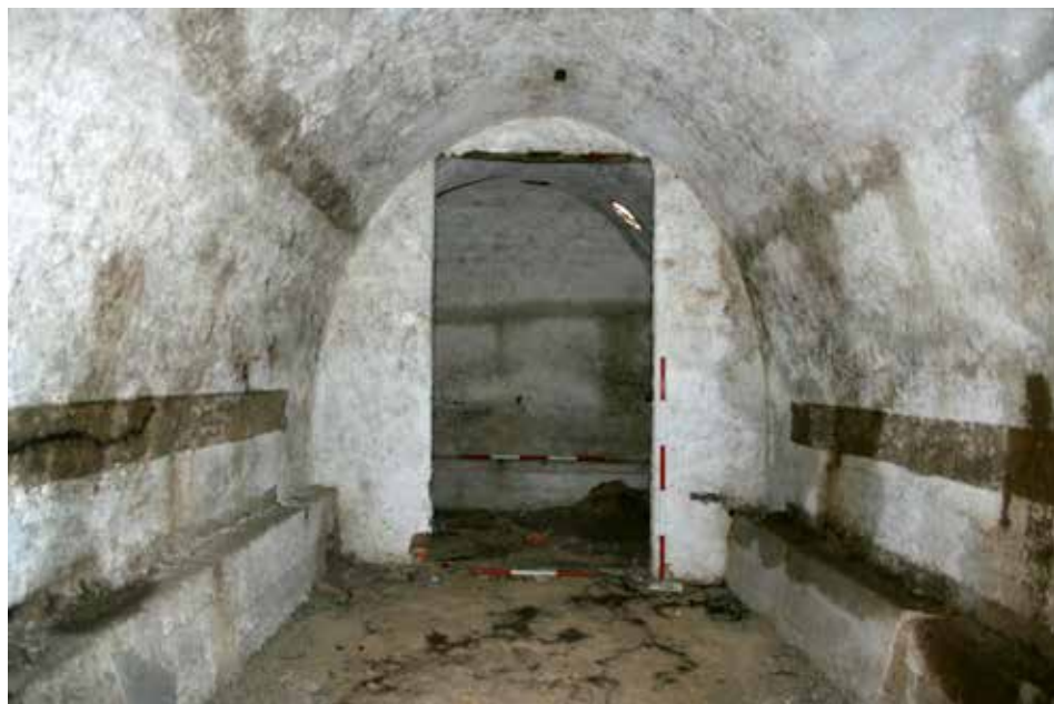
Obr. 9. Pohled od jihu na část protiletického krytu západně od budovy B. Zdroj Fotoarchiv Archaia Brno, o. p. s. – foto č. 5485-2012.
