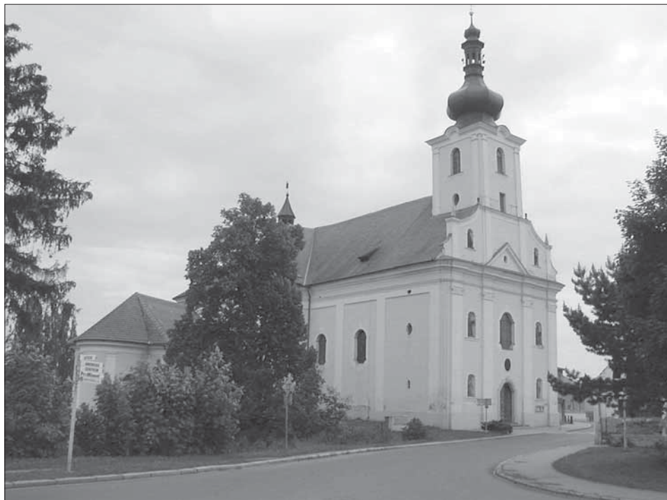
Obr. 1. Blovice. Kostel sv. Jana Evangelisty v pohledu od severozápadu.
