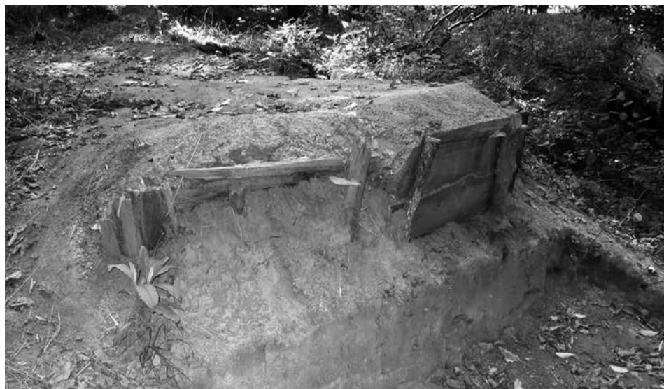
Obr. 3. Hrádek, k. ú. Žeranovice, okr. Kroměříž. Nahore půdorys zříceniny, šedou barvou jsou vyznačeny vandalsky poškozené plochy v r. 2005. Dole snímek poškození zříceniny v severní části jádra (Vrla 2005).
