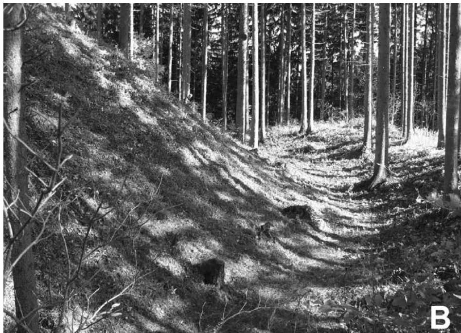
Obr. 8. Nový Šaumburk, k. ú. Podhradní Lhota, okr. Kroměříž. A – detail zdiva, dochovaný v jižní části jádra. Ze snímku je patrné, že zbytky zdiva jsou poškozovány divoce rostoucími nálety (Vrla 2007). B – jižní svah hradního jádra (vlevo) a přilehlý úsek příkopu s valem, stav po vyčištění areálu od náletové zeleně (Vrla 2008).
