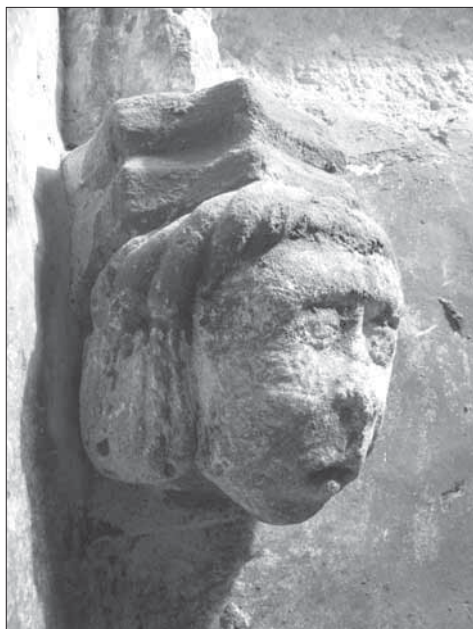
Obr. 7. Uherský Ostroh. Klenební konzola ve východním koutě místnosti.
