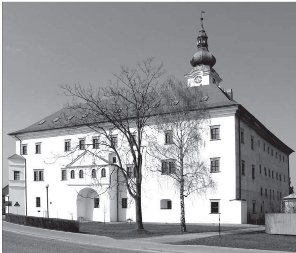
Obr. 1. Uherský Ostroh. Celkový pohled na zámek od východu.
