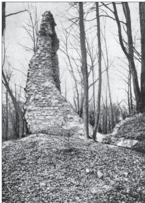
Obr. 8. Zvolen, Pustý hrad. Pohľad na juhovýchodné nárožie donjonu na Dolnom hrade. Podľa Menclová 1954, 69.
