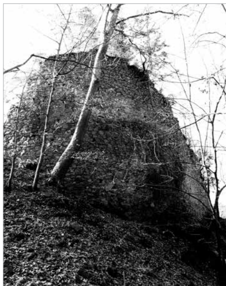
Obr. 5. Hrad Strádov, okr. Chrudim. Nejlépe dochované nadzemní zdivo jádra hradu. Pohled od východu. Stav v roce 2015. Foto J. Musil. Abb. 5. Burg Strádov, Bezirk Chrudim. Am besten erhaltenes oberirdisches Mauerwerk der Kernburg. Blick von Osten. Zustand im Jahr 2015. Foto J. Musil.
