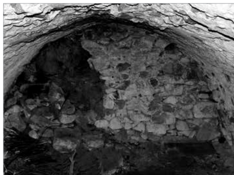
Obr. 6. Hrad Strádov, okr. Chrudim. Pohled do interiéru sklepa na předhradí. Pohled od severu. Stav v roce 2015. Foto J. Musil. Abb. 6. Burg Strádov, Bezirk Chrudim. Blick in das Innere des Kellers auf der Vorburg. Blick von Norden. Zustand im Jahr 2015. Foto J. Musil.
