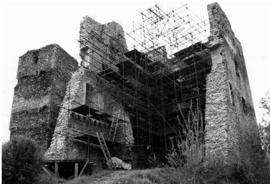
Obr. 9. Rokštejn, k. ú. Panská Lhota, město Brtnice. Horní palác a věž v letech 2005–2007 od východu při restauraci a stabilizaci zdiv. Foto S. Jirků.
