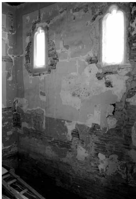
Obr. 3. Kopčany, okr. Senica, Kostol sv. Margity Antiochijskej. Južná stena po čiastkovej obnove. Abb. 3. Kopčany, Bezirk Senica, Kirche St. Margaretha von Antiochien. Südwand nach teilweiser Restaurierung.
