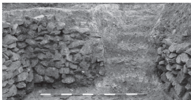
Obr. 187. Staré Hory III (výzkum 2004–5). Pozůstatky zahloubené dřevohliněné stavby s kamennými základy 5603. Ortogonální pohled na texturu vnitřního líce zdiva v průčelí suterénu se vstupní šjí ve fázi exkavace téměř všech uloženin ve výplni stavby, avšak s ponecháním nejstarších horizontálních vrstev, vzniklých bezprostředně po zániku stavby, nebo jako úprava suterénu v době jeho existence (nahore). Tentýž pohled po odebrání všech kulturních vrstev až na podloží. Foto archiv ARCHAIA Brno.
