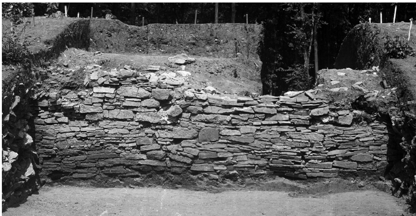
Obr. 132 – R01. Čelní kamenná zeď – čelní pohled.
