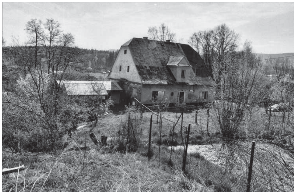
Obr. 3. Hradec, areál č. p. 7 – poloha údajného drobného středověkého opevnění, pohled od severu. V popředí betonová nádrž pod pramenem. Foto D. Prix, 17. 4. 2009.
