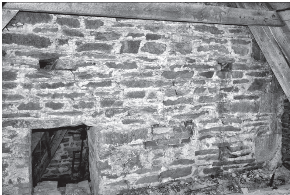
Obr. 2. Pařížov, kostel sv. Máří Magdalény. Pohled z púdy lodi na spodní část východního průčelí věže s rytými spárami. Foto J. Varhaník, 2007.
