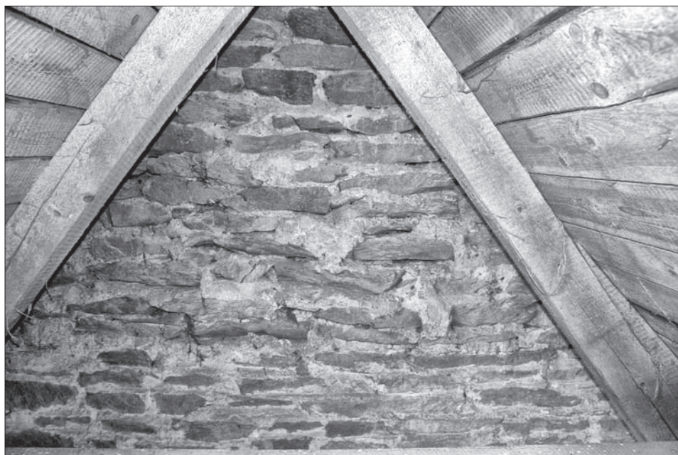
Obr. 3. Pařížov, kostel sv. Máří Magdalény. Pohled z púdy lodi na horní část východního průčelí věže, nad úrovní hambalků krovu, kde líc zdíva není povrchově upraven. Foto J. Varhaník, 2007.
