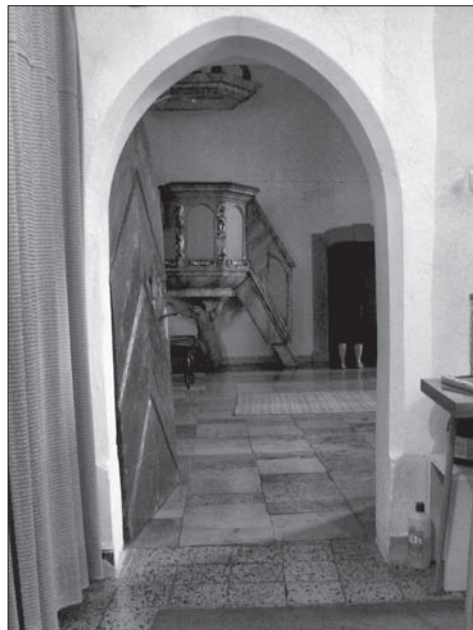
Obr. 11. Valašské Meziříčí-Krásno, kostel sv. Jakuba Většího. Portál vstupu do bývalé jižní před síně, pohled od jihu.
