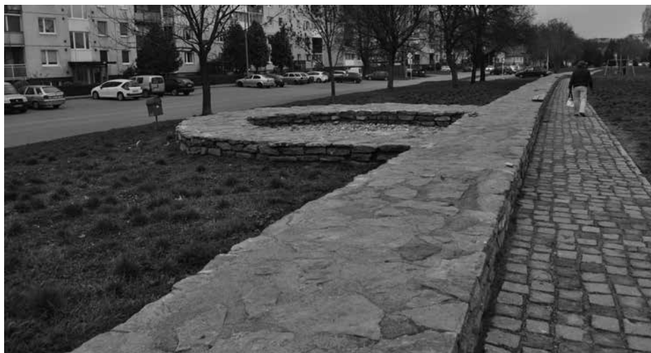
Obr. 28. Severný úsek opevnenia v Sabinove. Po archeologickom výskume bol prezentovaný náznakom pôvodného pôdorysu kameným múrikom. Foto A. Škrinárová.
