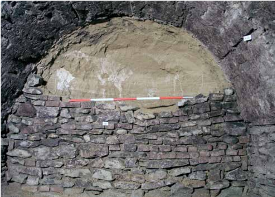
Obr. 9. Chrudim, Hradební ul. Detail odstraněné zazzdivky západního výklenku druhého patra sklepa. Foto J. Frolík. Abb. 9. Chrudim, Hradební-Gasse. Detail der entfernten Einmauerung der westlichen Nische des zweiten Kellergeschosses. Foto J. Frolík.
