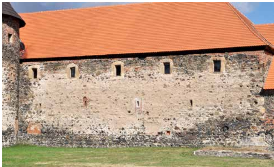
Obr. 8. Hrad Švihov, jižní průčelí sýpky. Foto J. Varhaník, 2015. Abb. 8. Burg Schwihau, Südfassade des Speichers. Foto J. Varhaník, 2015.
