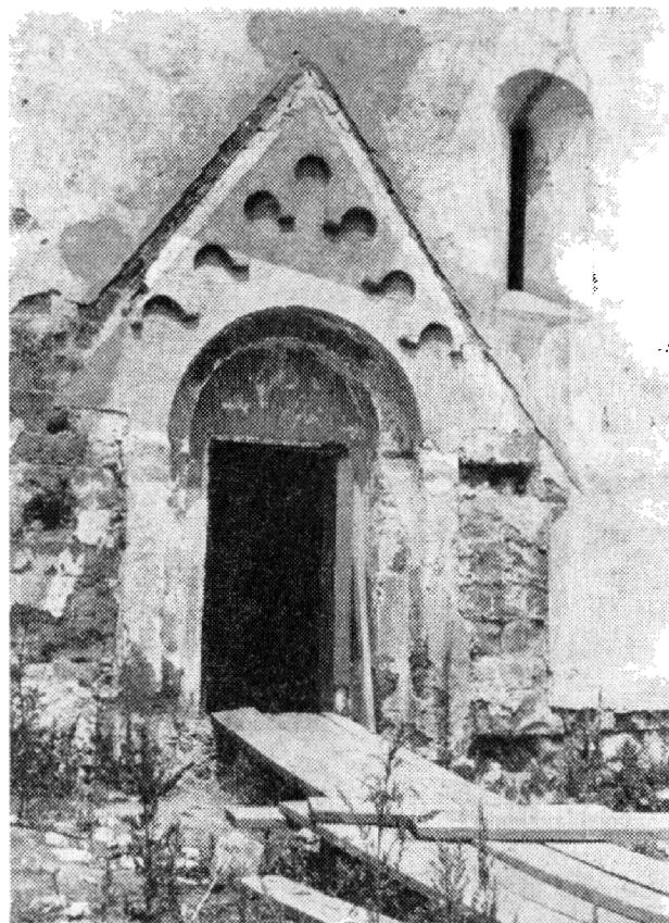
Obr. 2. Svinica, okr. Košice-vidiek. Románsky vstupný portál a okno. Foto D. Čaplovič.
