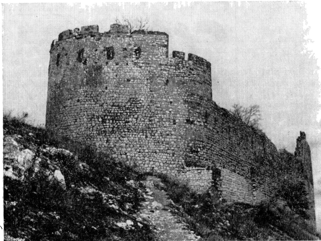
Obr. 6. Děvičky, hrad okr. Břeclav. Pohled na hrad od předsunutého opevnění. Foto T. Durdík.
