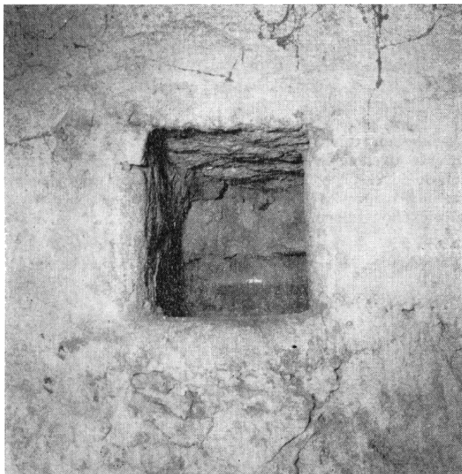
Obr. 8. Vochov (okr. Plzeň-sever), čp. 10. Pohled do ústí skrýše ve zdivu sýpky po vyjmutí uzavíracího kamene. V dolní části otvoru patrné hrdlo svisle zapuštěného, uvnitř hnědě glazovaného hrnce. (Foto a kresby J. Škabrada). Za upozornění na skrýš děkujeme VI. Švábkovi.
