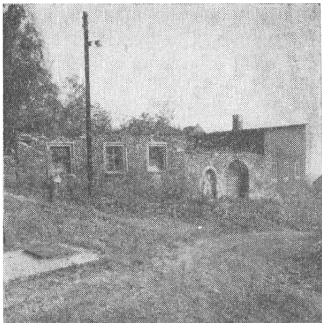
Obr. 8. Vinařice čp. 13. (?) (okres Chomutov), průčelí usedlosti v pohledu z návsi. Vlevo zdívo přízemí obytné části někdejšího domu s renesančními ostěními oken, uprostřed vjezd s pozdně gotickou vstupní brankou, vpravo nově upravené bývalé hospodářské stavení, rovněž s pozdně gotickým jádrem. Foto V. Šafránek, 1982.
