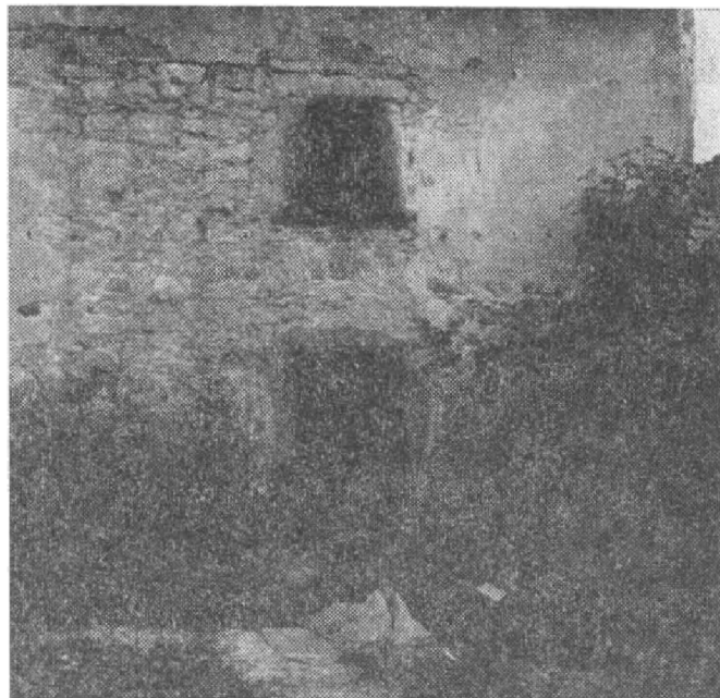
Obr. 7. Libouchec čp. 57 (okres Ústí nad Labem), dvorní průčelí sýpky ze 16. století s pozdně gotickým vstupním portálem. Foto V. Šafránek, 1981.
