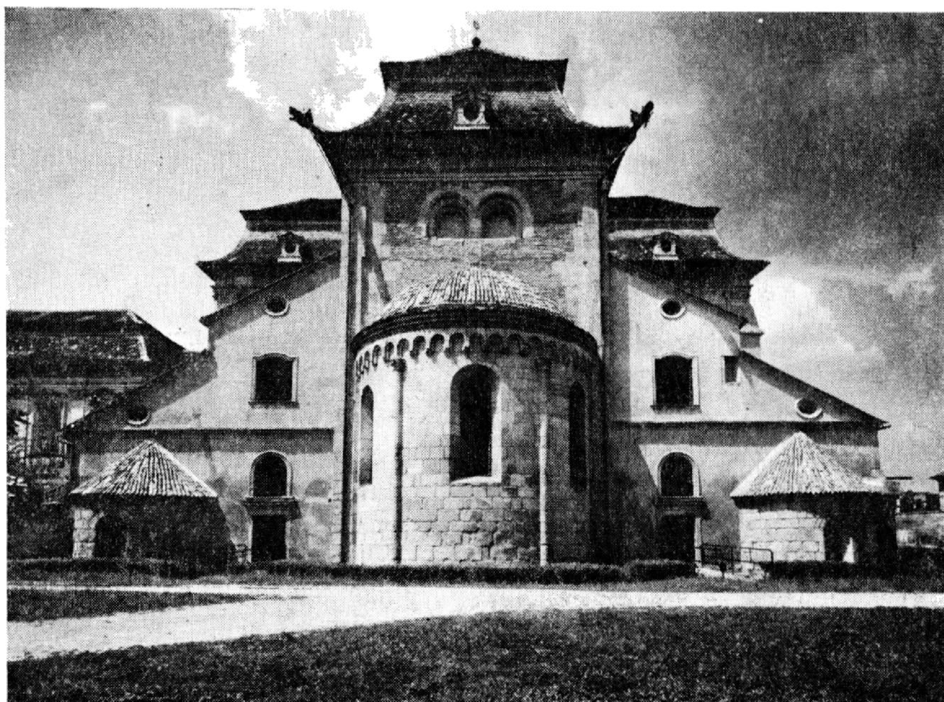
Obr. 7. Východní záměr pozdněrománského klášterního kostela. Foto: SÚPPOP Praha, Č. Síla.
