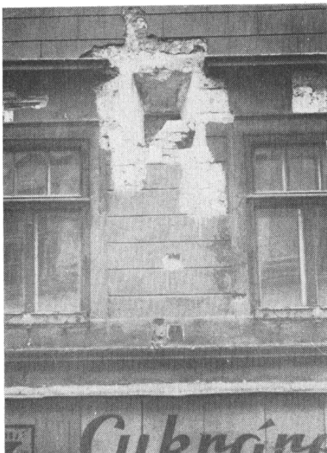
Obr. 15.–16. Banská Štiavnica (okres Žiar nad Hronom). Varianty vnějšího utváření větracích otvorů ve fasádách s šikými, ven rozevřenými špaletami.
