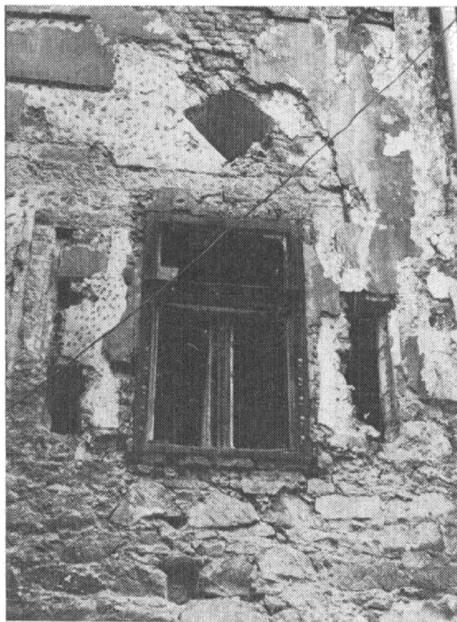
Obr. 15.–16. Banská Štiavnica (okres Žiar nad Hronom). Varianty vnějšího utváření větracích otvorů ve fasádách s šikými, ven rozevřenými špaletami.
