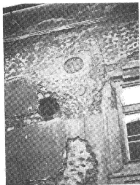
Obr. 13.–14. Banská Štiavnica (okres Žiar nad Hronom). Drobné větrací otvory čtvercového a kruhového tvaru v průčelí domů.
