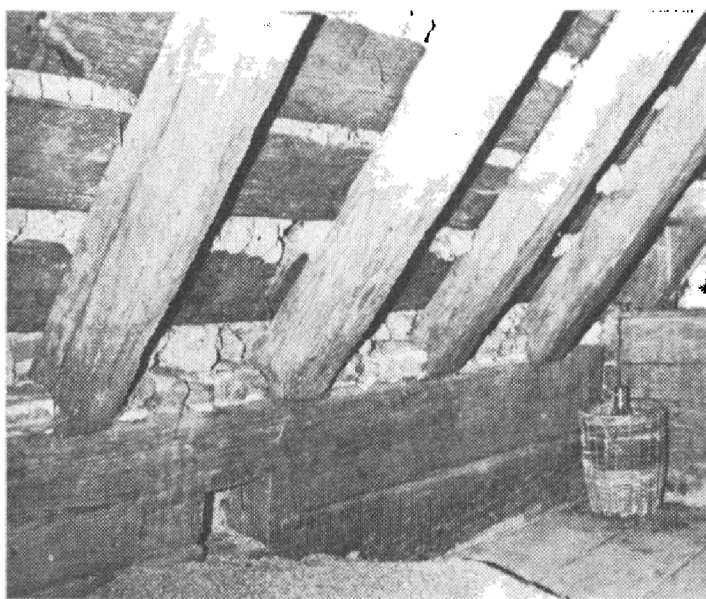
Obr. 4.–5. Krnin řp. 3 (okr. Český Krumlov). Izolační dřevohliněná konstrukce (lepenec) v podstřeší zadní patrové komorové části pozdně gotického domu – usazení krokví, nosoucích bednění a mazaninu, na roubeném věnci, a pohled vzhůru ke hřebeni střechy mezerou mezi vnějším licem hliněné izolace a vrchním krokem s krytinou.
