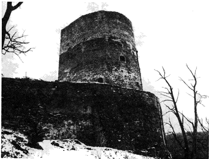
Obr. 1. Bitov, okr. Znojmo. Válcový donjon s břitem v zadní části jádra hradu. Pohled od SV.
