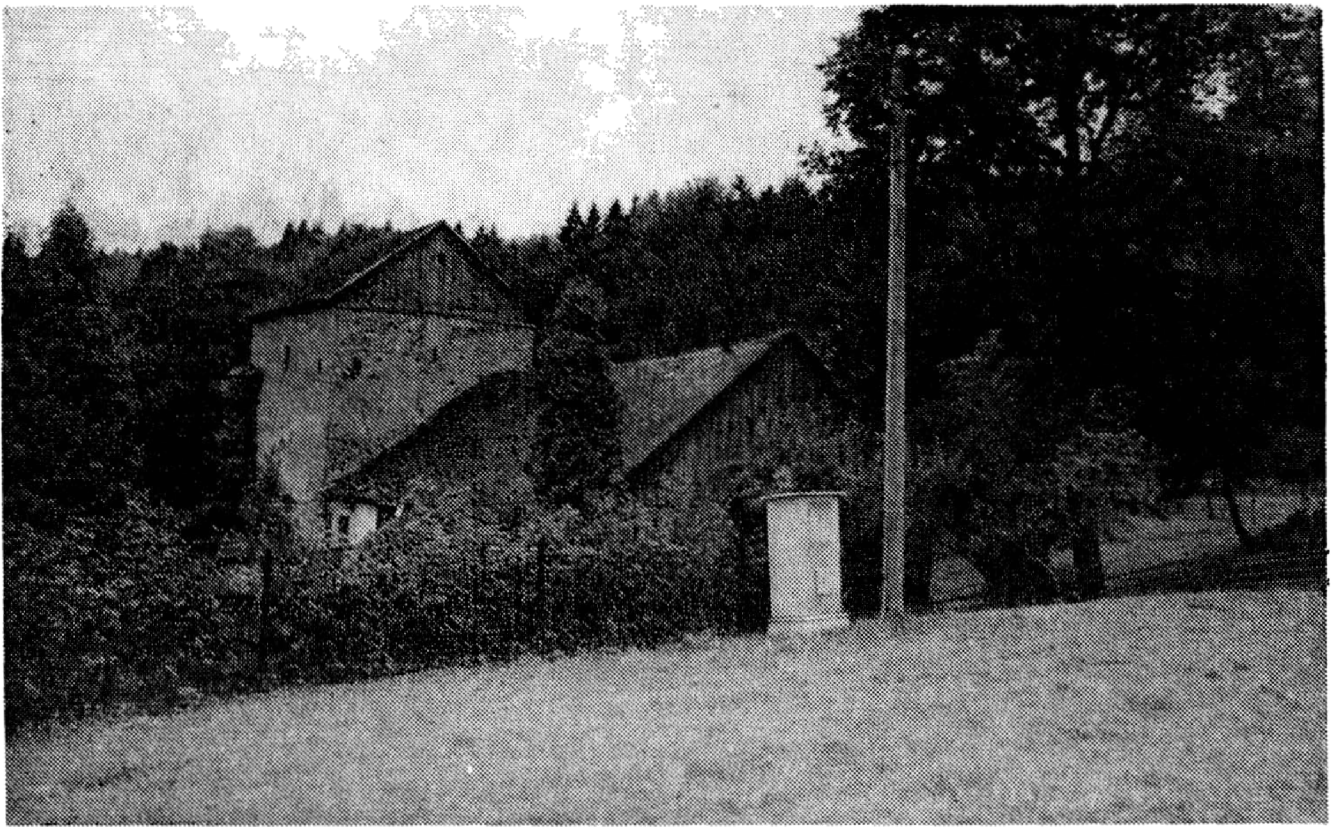
Obr. 6. Kouskova Lhotka, pohled na zbytky tvrže. Vlevo věž, uprostřed stodola v místech gotické budovy, vpravo zbytky příkopu a valu (foto M. Rykl).
