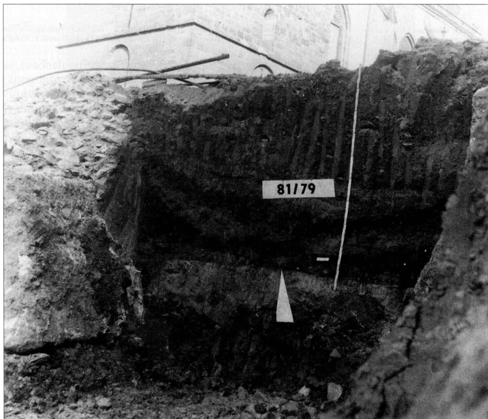
Obr. 12. Olomouc - Mořické nám./Úzká ulice. Řez souvrstvími zásypu zahloubeného objektu 81/79, vzniklý odbagrová-ním v souvislosti s rozšířením stavební jámy v její jihovýchodní části. Pohled od jihozápadu. Foto J. Bláha.
