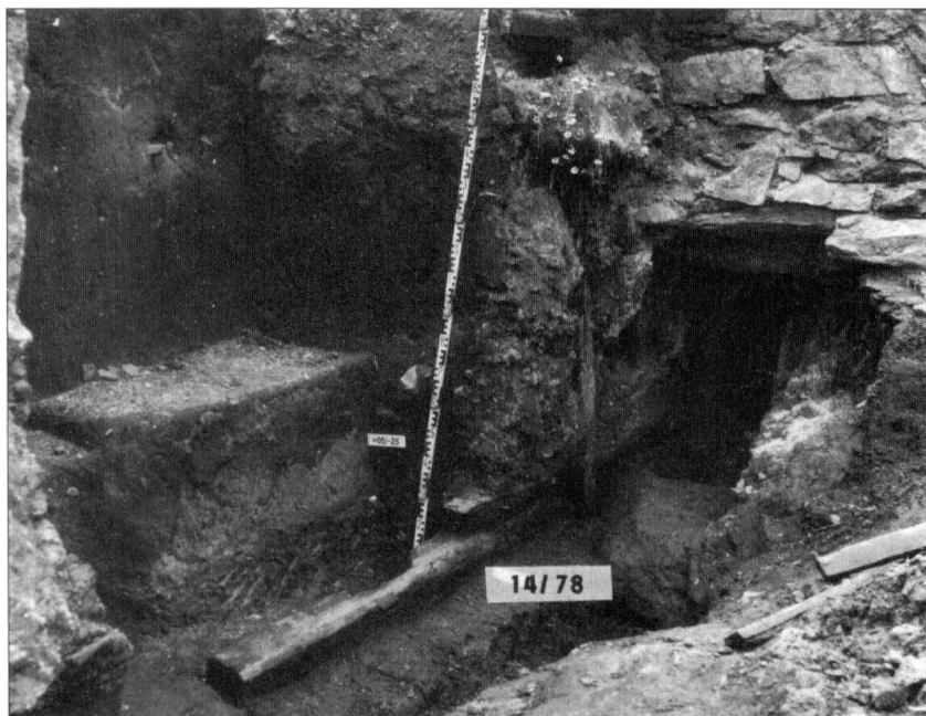
Obr. 9. Olomouc - Úzká ul. (staveniště OD Prior). Postup preparace jihovýchodního nároží objektu 14/78 s dochovanou dřevěnou výztuhou stěn a příslušnými kůly. Dole je patrný v základech druhotně použitý konstrukční článek – hranolovitý práh či vaznice z jedlového dřeva. Pohled od severozápadu. Foto J. Bláha.
