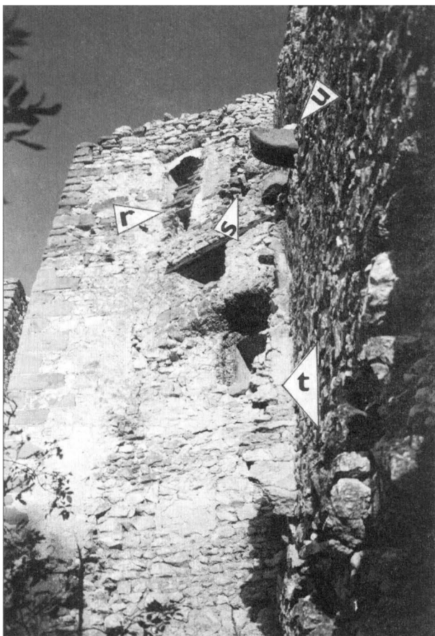
Obr. 2. Sústava prevétov v severozápadnom exteriérovom kúte horného hradu (označenie prevétov zodpovedá označeniu na obr. 1A). Foto autor, VIII. 1998.
