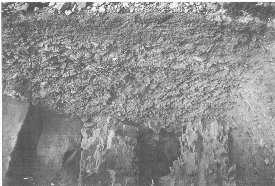
Obr. 10. Říčany hrad, okr. Praha-východ. Sonda 8. Základový vkop obvodové zdi jádra hradu s nádvoří hranou (vlevo) a v důsledku vyvrácení hradby (směrem do prava) posunutě bloky jejího základového zdiva. Foto T. Durdík.
