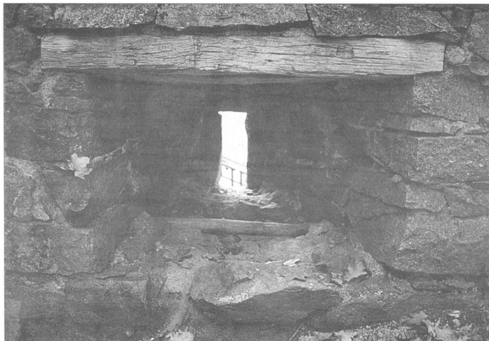
Obr. 7. Hrad Zvíkov, střelnice pro hákovnici v parkánové hradbě z roku 1457. Foto J. Varhaník 1998.
